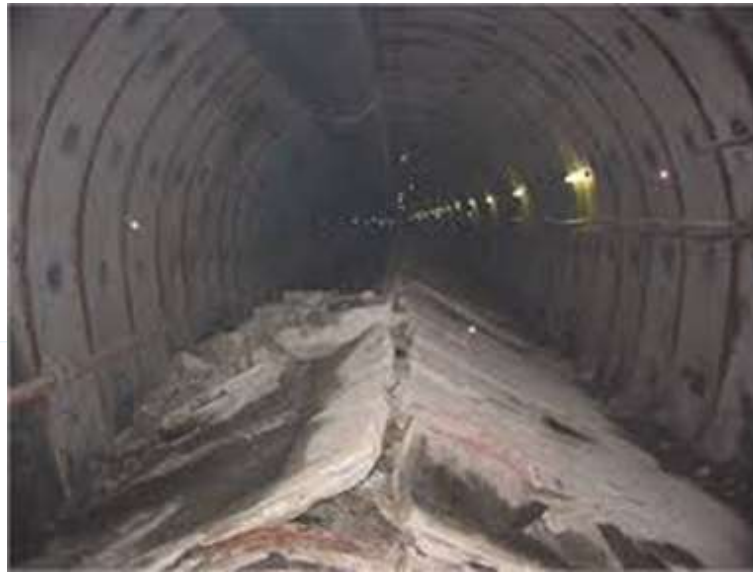
Fig. 12 : Bottom heaving
